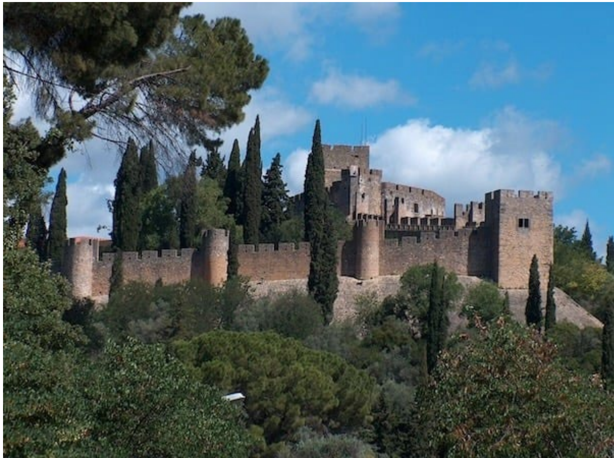
Figuur 6. Die kasteel in Tomar in die distrik Santarém
